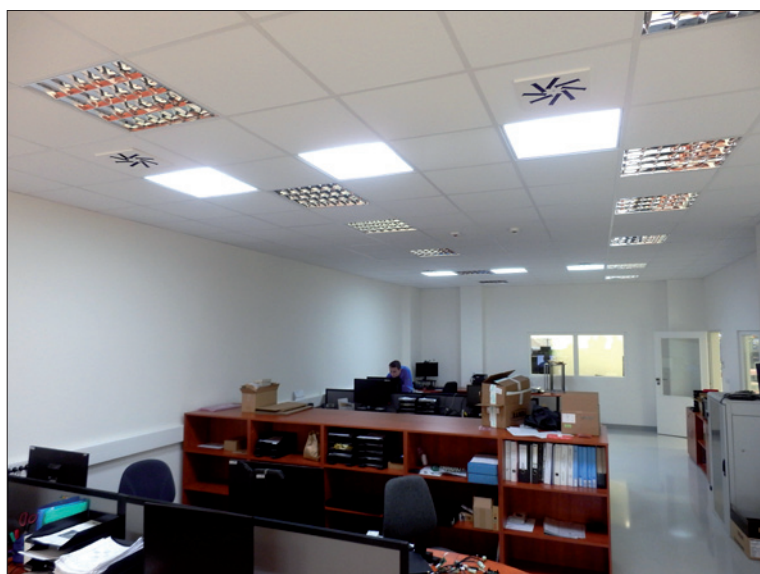
Obr. 3. Kancelář – šest světlovodů Solatube 330DS- -530mm
