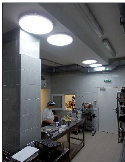
Obr. 2. Bezokenní školní kuchyň s vyhovujícím sdruženým osvětlením podle ČSN 36 0020 prosvětlená pěti světlovody Solatube® 330DS-530 mm délky 4 500 mm
