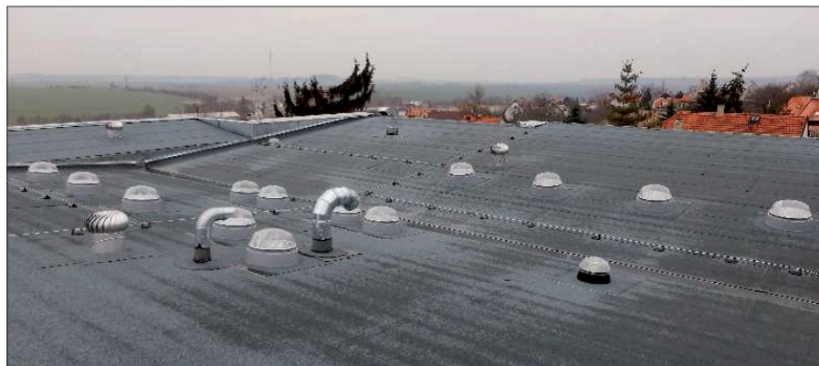
Obr. 1. Osazení světlovodů Solatube® na ploché střeše s živičnou fólií
