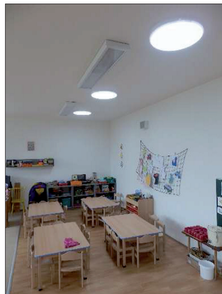
Obr. 3. Dětská herna s vyhovujícím denním osvětlením podle ČSN 74 0580-3 prosvětlená čtyřmi světlovody Solatube® 330DS-530 mm délky 1 500 mm
