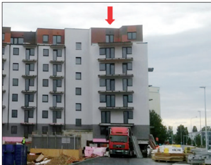
Obr. 2. Pohled na novostavbu
